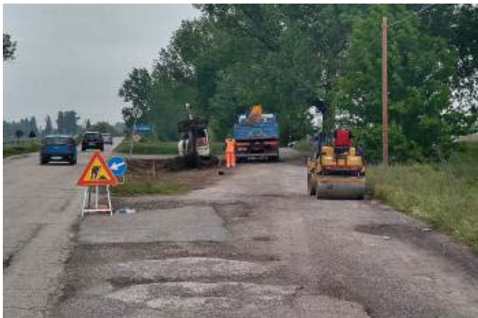
Il cantiere della ciclabile fra Rivarolo del Re e Sabbioneta
