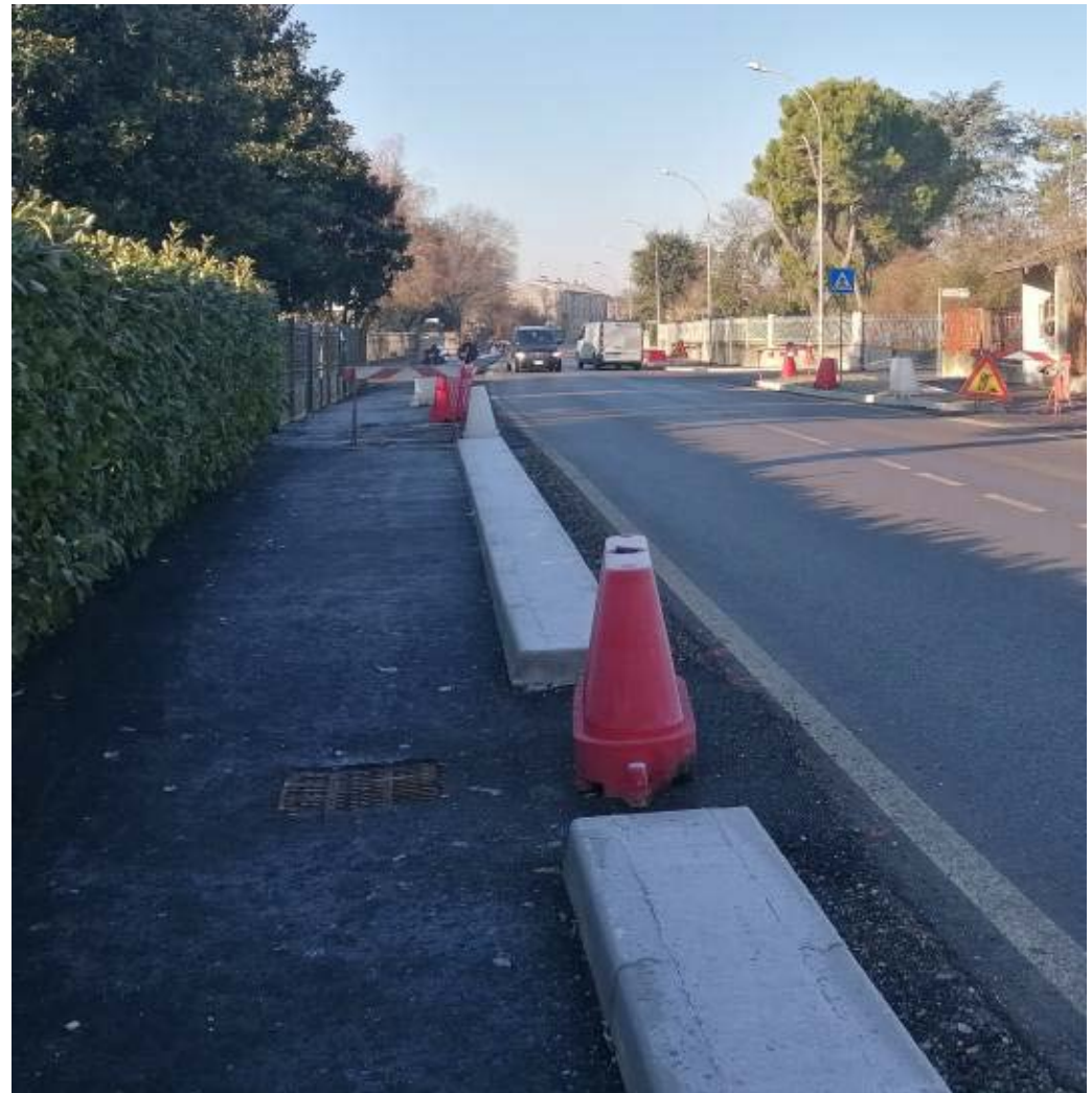
Sono in dirittura d'arrivo i lavori lungo via Trioni per la nuova pista ciclabile
