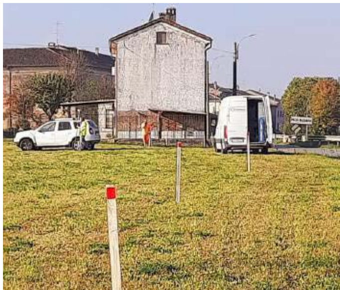
Il cantiere e i picchetti posizionati sulla futura pista ciclabile
