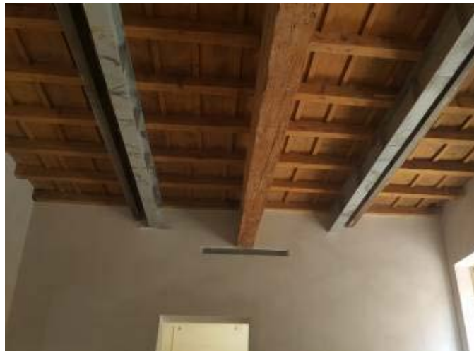
Il soffitto di una delle sale del palazzo dei principi messo in sicurezza
