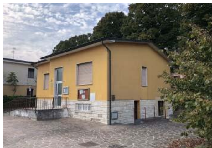
L'edificio individuato come sede del poliambulatorio
